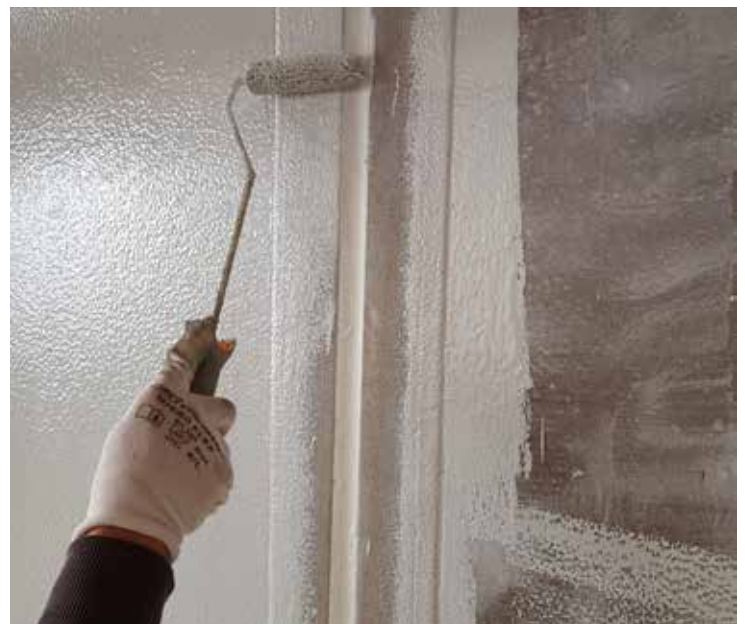
Bild 6: Rissüberbrückende Wandbeschichtung auch über geschlossene Fugen
