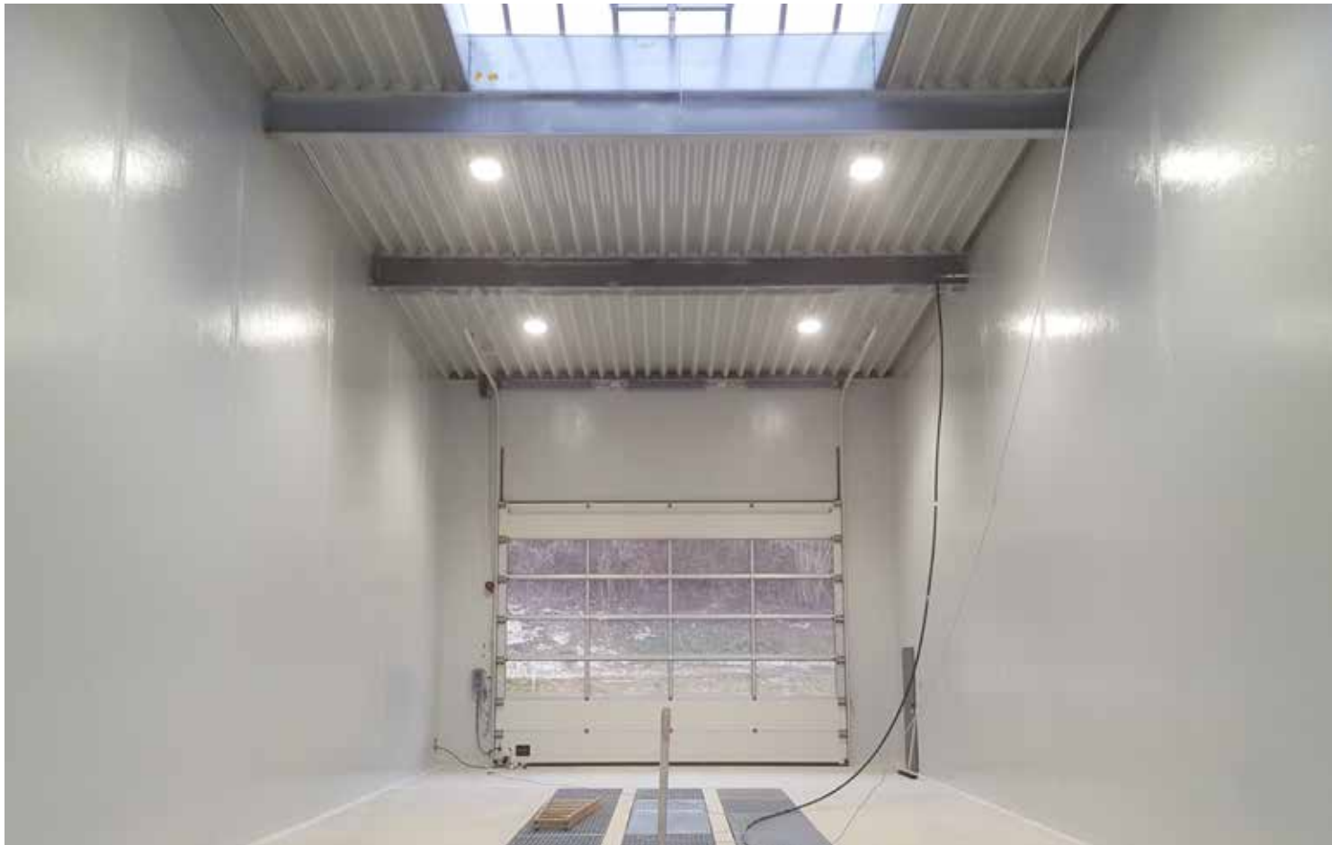
Bild 7: Funktionell und optisch sehr ansprechend erstrahlt die neue Waschhalle
