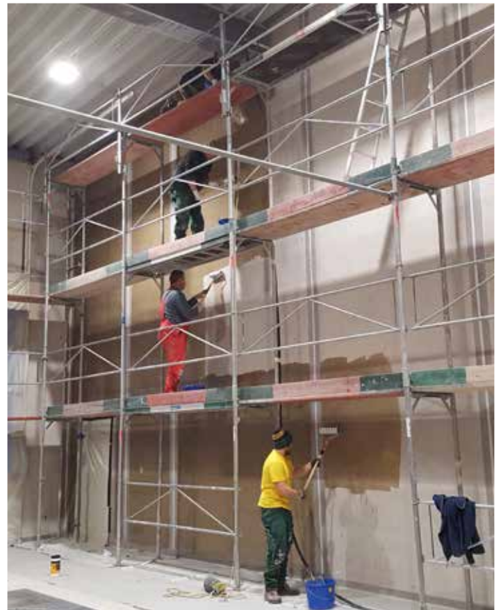
Bild 3: Grundierung der Wandfläche mit Sikafloor®-156
