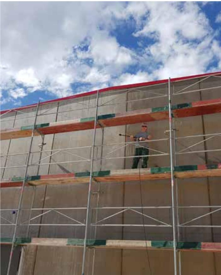
Bild 2: Grundierung der Wandfläche mit Sikagard®-552 W Aquaprimer
