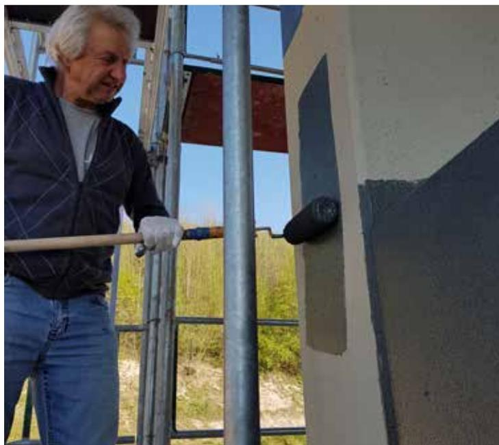
Bild 5: Einfacher Auftrag der Sika Produkte mittels Roller
