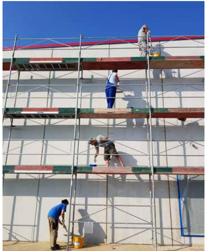
Bild 3: Füllbeschichtung mit Sikagard®-545 W Elastofill
