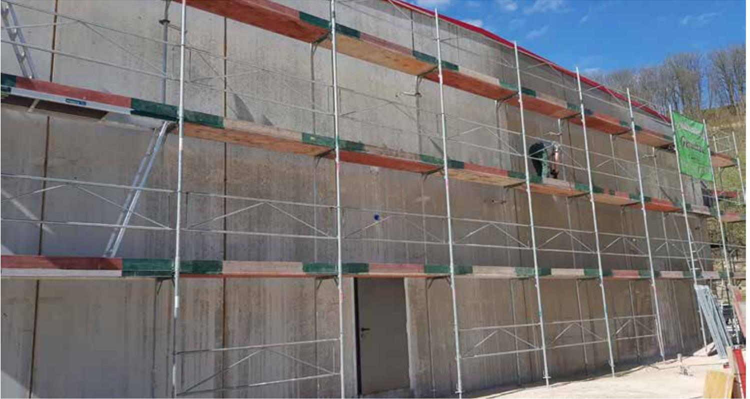
Bild 1: Nach Einrüstung der gesamten Wandfläche konnte mit der Sanierung der Fassade begonnen werden
